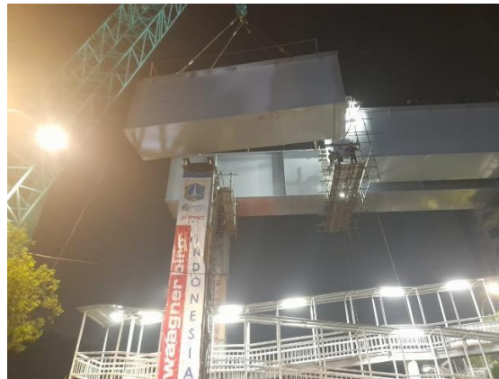
Gambar 4. 4 Lifting Steel Box Girder (Sumber :Dokumentasi Pribadi)
