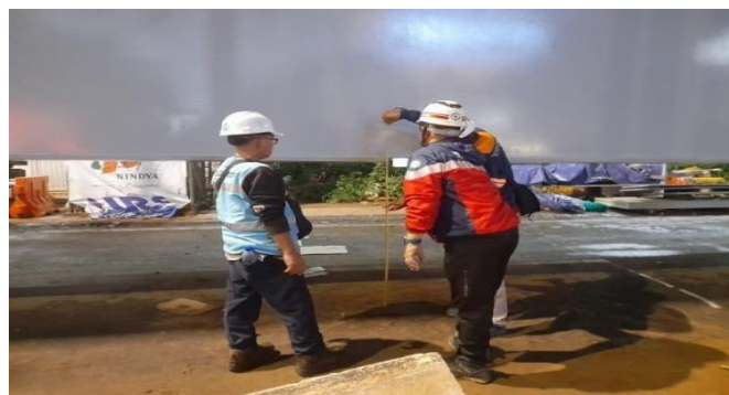
Gambar 4. 3 Loading Test (Sumber :Dokumentasi Pribadi)
