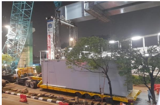
Gambar 4. 2 Pemasangan Wire Rope Sling (Sumber :Dokumentasi Pribadi)
