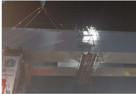
Gambar 4. 5 Pemasangan Baut (Sumber :Dokumentasi Pribadi)
