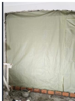
Gambar 3. 3 Pemasangan Pelastik Cor
