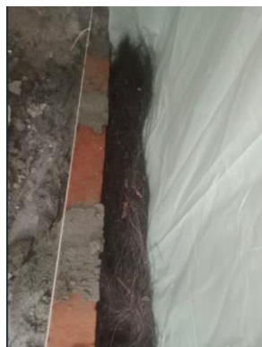
Gambar 3. 4 Pemasangan Injuk Dan Pipa Subdrain
