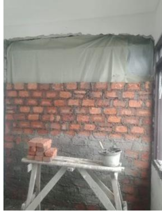
Gambar 3. 5 Pemasangan Bata Merah
