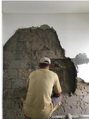
Gambar 3. 2 Pembongkaran Dinding
