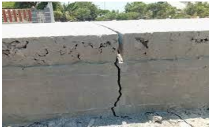
Gambar 3.3 Retakan beton
